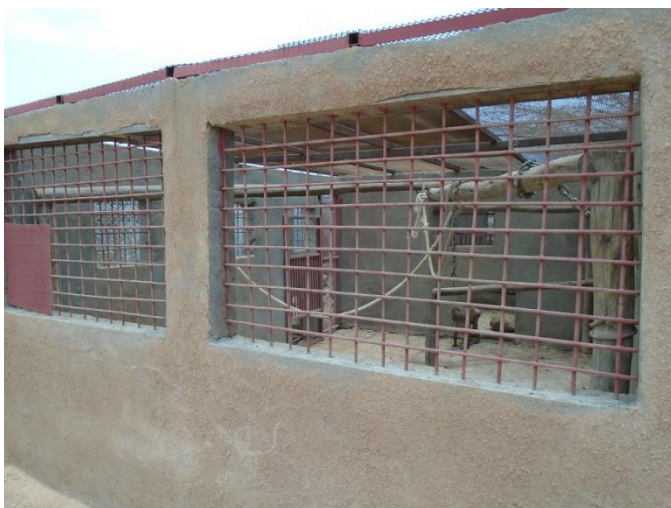
Bâtiment en dur
